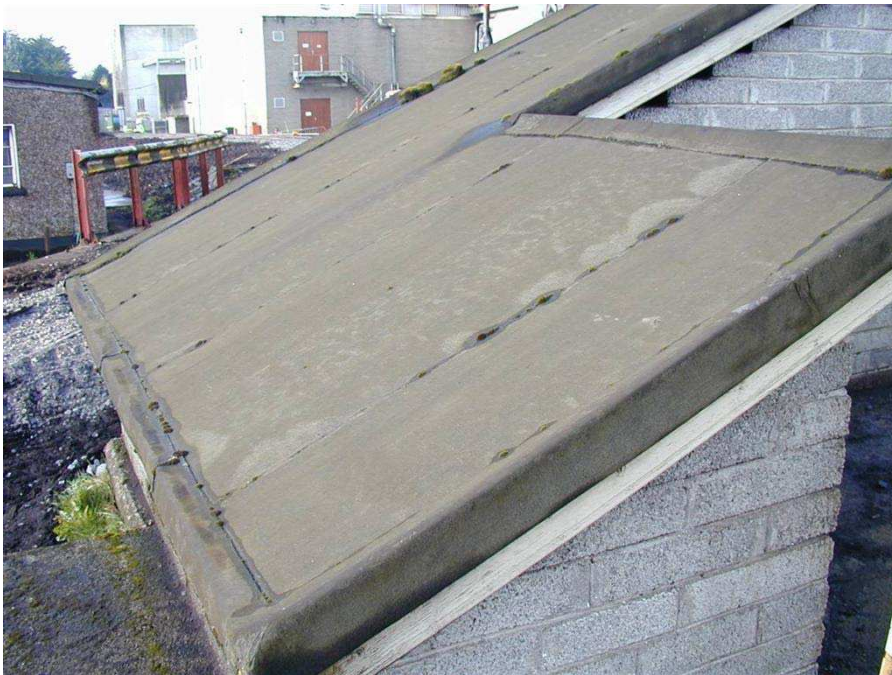
Слика 4.7. Азбестне кровне плоче
