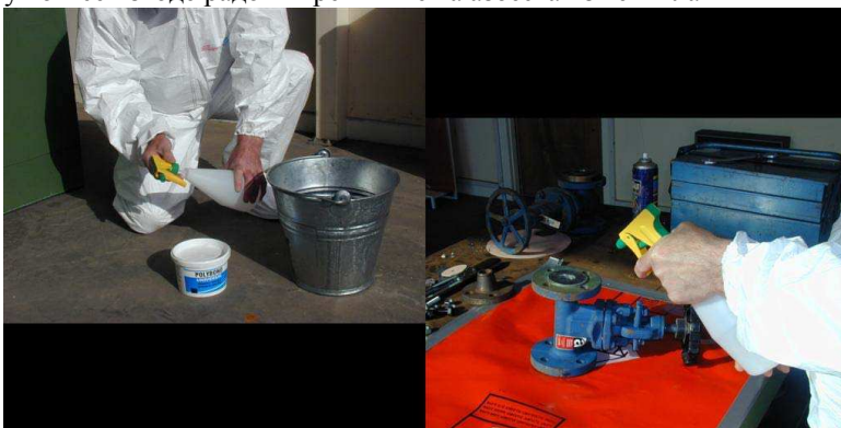
Слика 11.4 Овлаживање слоја азбеста на вентилу
