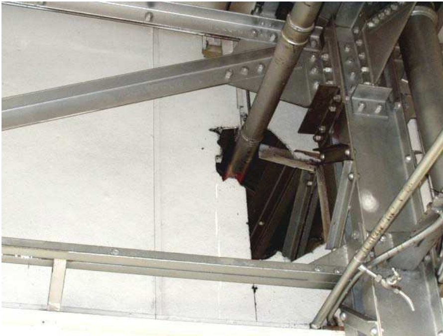
Слика 4.3. Преградни зид од плоче изоловане азбестом. Овај пример показује практичне потешкоће у конструкцији одговарајућег поклопца и показује површине где се може прикупити азбестна прашина током процеса уклањања.
