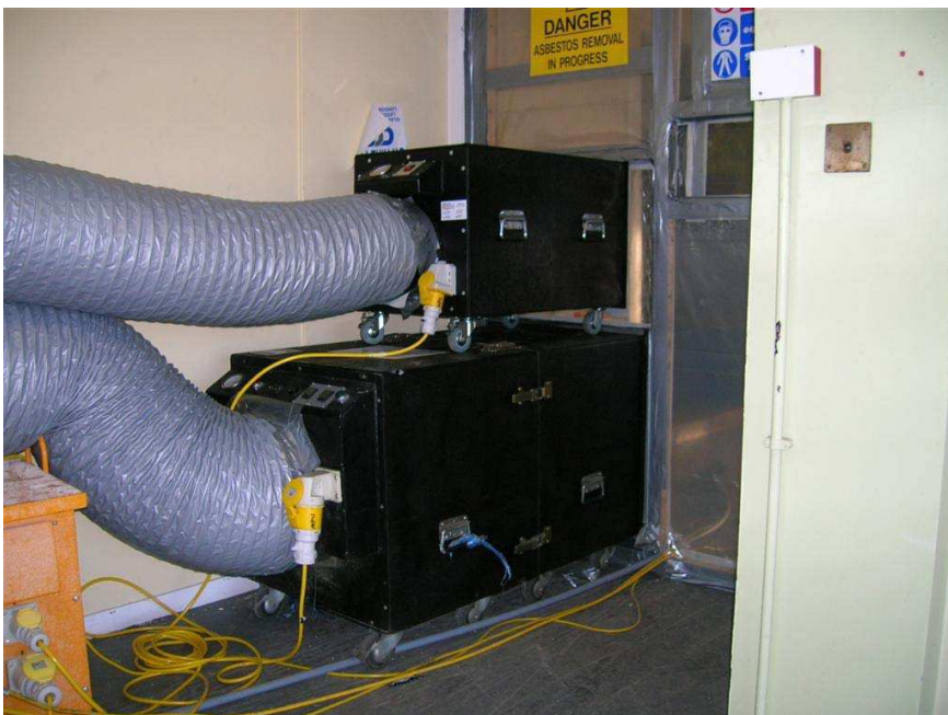
Слика 12.2. Јединице за негативан притисак и испуштање ваздуха, панели за надзор и ознаке упозорења.
