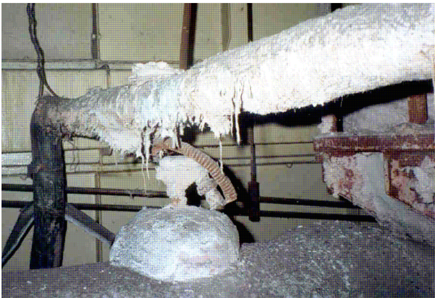
Слика 4.8. Азбестна изолација цевовода
