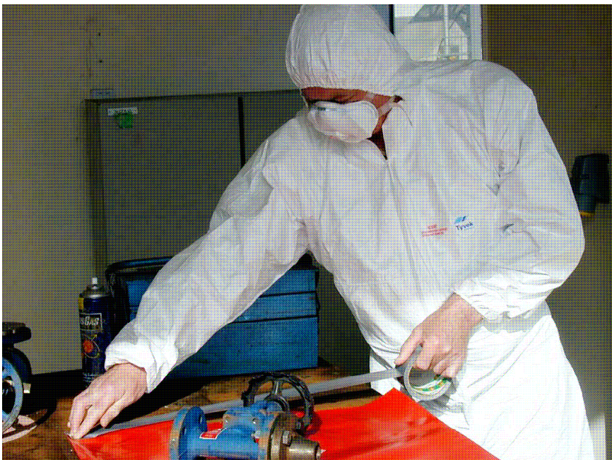
Слика 11.3. Користите траку и политен да заштитите простор у ком се изводе радови пре чишћења азбеста из вентила
