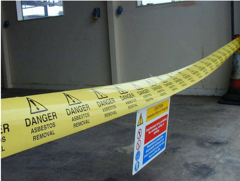
Слика 11.1. Употреба траке за обележавање и ознаке за ограничавање уласка у простор
