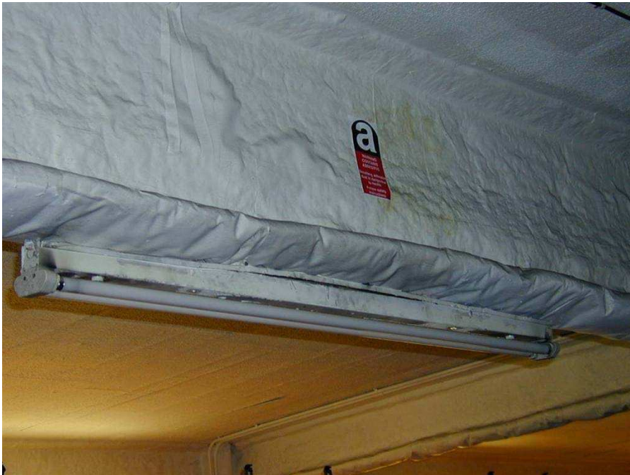
Слика 4.11. Азбестна изолација на челичној конструкцији
