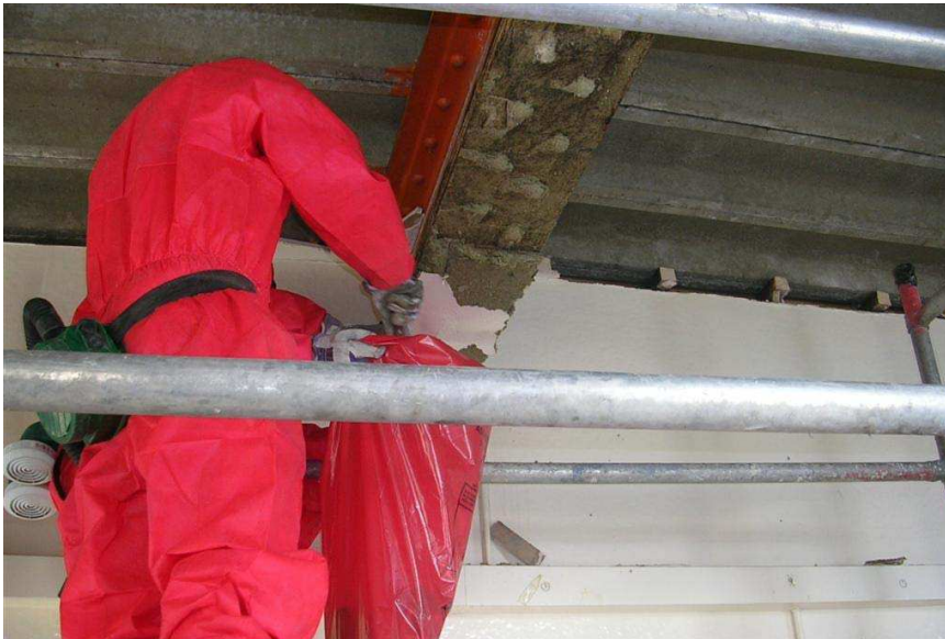
Слика 12.11. Паковање отпада у кесе близу места уклањања како би се спречило излагање.
