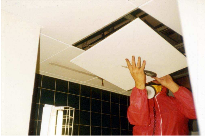
Слика 12.13. Пажљиво уклањање азбестне плоче
