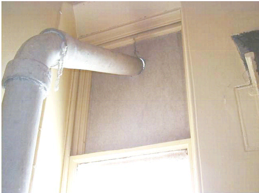
Слика 4.5. Азбестни сулундар са азбестним заптивачима пролази кроз азбестни панел.
