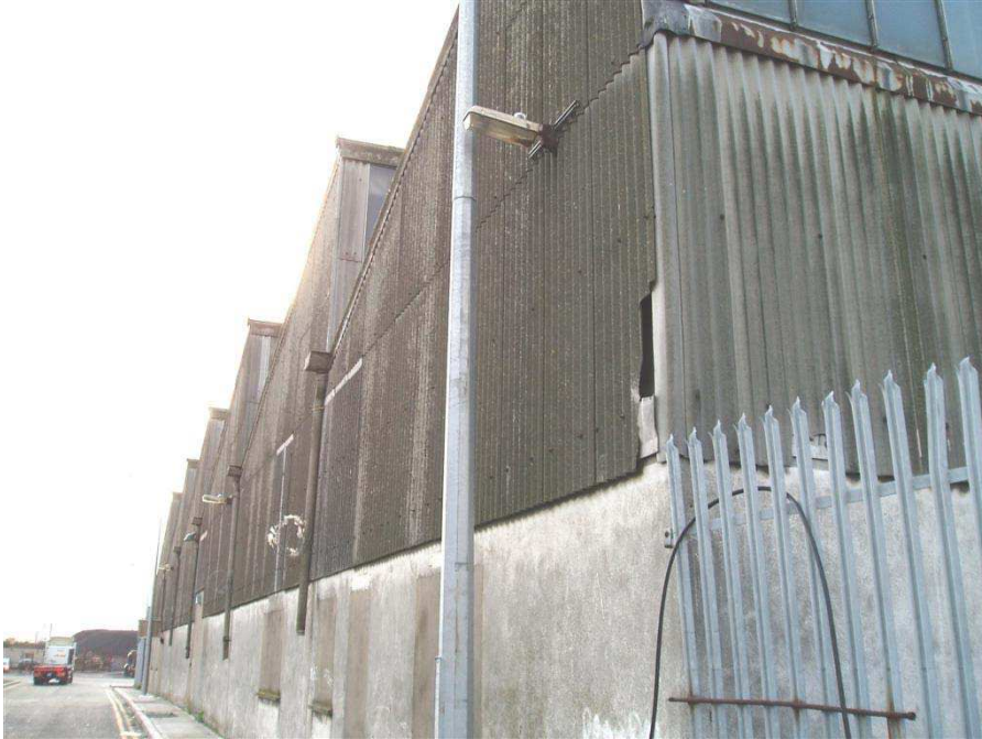
Слика 4.10. Фабрика обложена азбестним цементом
