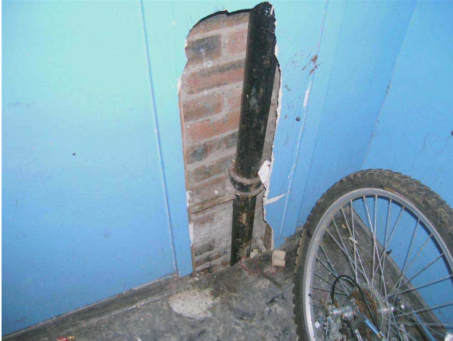
Слика 6.4. Азбестна плоча за изолацију; треба размотрити уклањање плоче јер је на тој локацији подложна оштећењима
