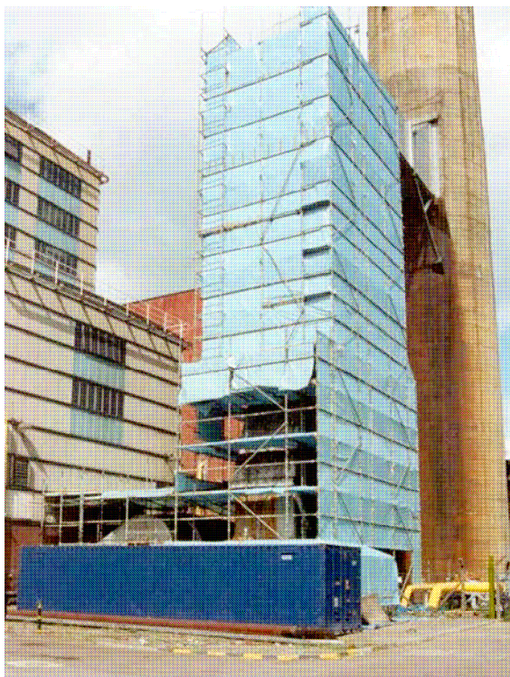
Слика 12.3. Затворени простор за уклањање остатака од гасовода
