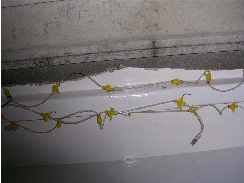
Слика 12.10. Пример убризгавања на више тачака који се користи током квашења прскане азбестне изолације.
