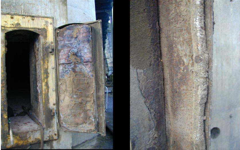
Слика 4.12. Азбестни заптивач на вратима димњака. Слика десно је крупни план заптивача.
