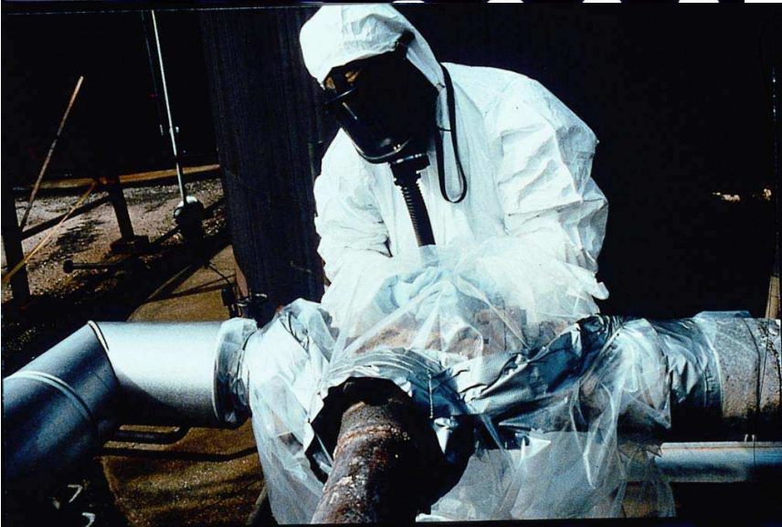
Слика 12.12 Кесе са рукавицама које се користе за контролисано уклањање азбестних остатака (фотографије су власништво INRS).
