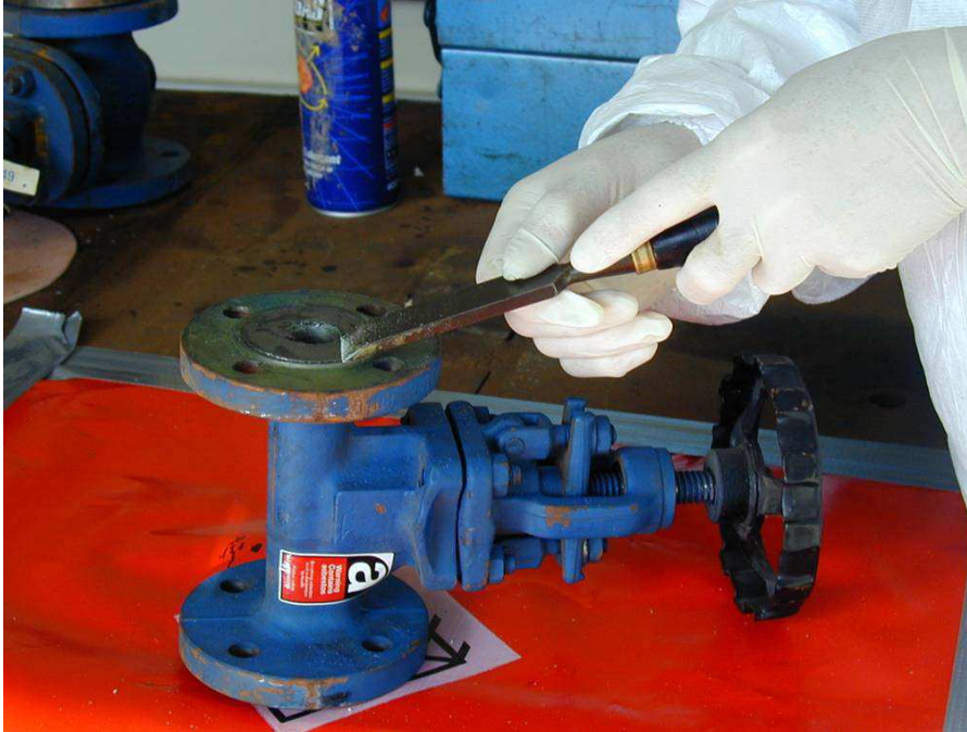
Слика 11.5. Користите ручни алат само за чишћење азбестних остатака на вентилу
