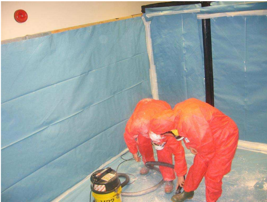
Слика 7.1. Практично оспособљавање о употреби усисивача типа X за уклањање симулиране контаминације (талк у праху). Сliku је обезбедио HSE, Велика Британија.
