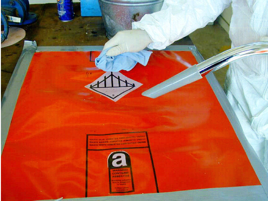
Слика 11.7. Пажљиво чишћење простора где се изводе радови, са усисивачем типа X и мокрым крпама.
