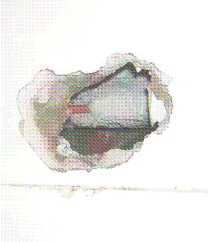
Слика 4.4. Пробијање зида како би се показала азбестна изолација цев
