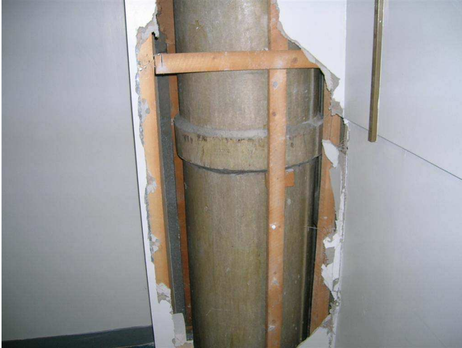
Слика 4.2. Делимично уклоњена азбестна изолациона табла, како би се показала азбестна цев иза ње.
