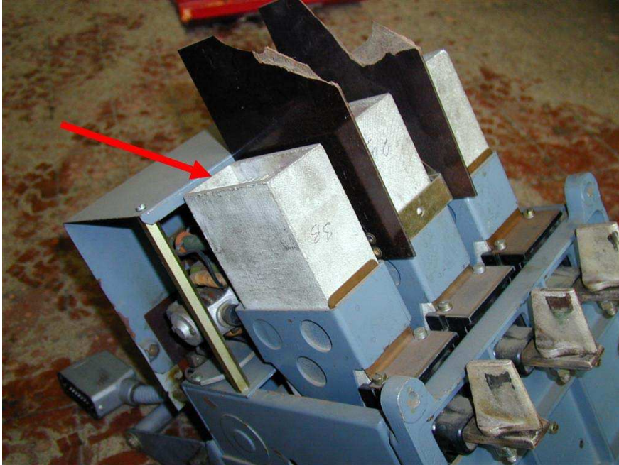
Слика 18.2. Компоненте које садрже азбест у електричним прекидачима високе волтаже
